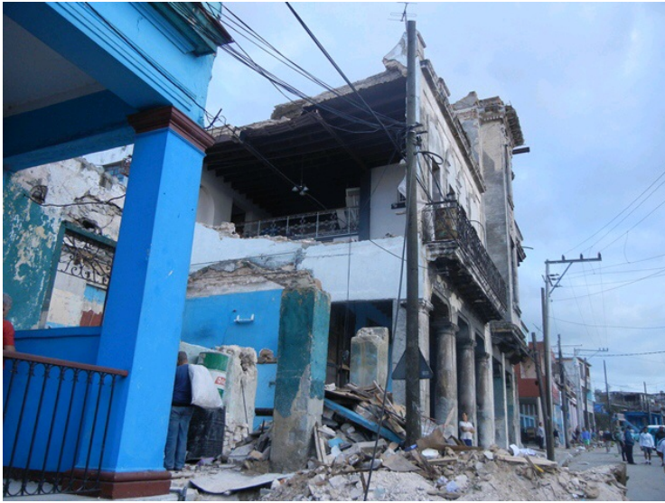
La tornade a endommagé ou détruit près de 1200 habitations.
